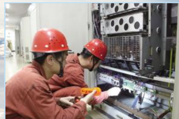
检查电气柜设备
